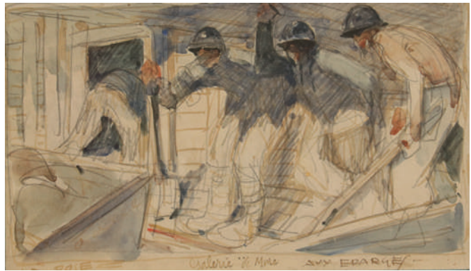
86 «La pose, galerie de mine aux Eparges»
